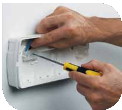
Подсоедините кабели при помощи винтовых зажимов 2x2,5 мм 2 .
